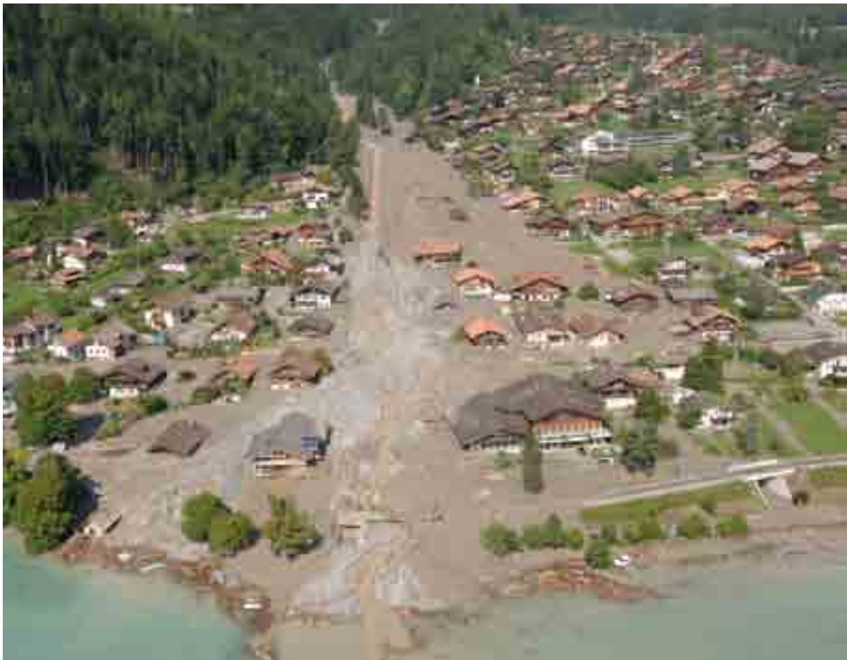
Abb. 3: Durch alpine Wildbachtätigkeit (Mure) zerstörte Siedlungsteile, die gefahrenignorant direkt am Unterlauf (auf dem Schwemmkegel) des Wildbachs errichtet wurden (Quelle: http://www.vol.be.ch/site/fr/m_ccfw_big-picture.htm?picurl=naturgefahren-murgaenge-murgang-brienz-glyssibach.jpg , 12.11.08).
