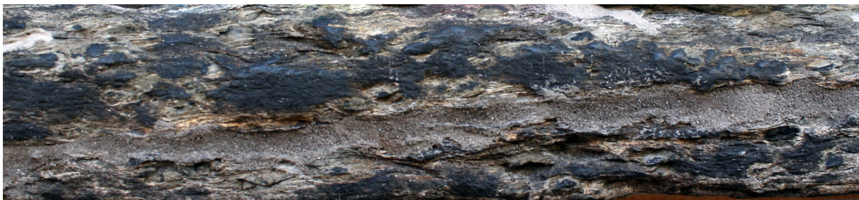
Abb. 5 Oberflächenverschluss (mineralisch) an der Seite der Platte. Die Schale mit großer Kluftweite wurde zur Stabilisierung mit einem vorpigmentierten Mörtel auf Acrylatbasis angebösch. Plattendicke ca. 6 cm.
