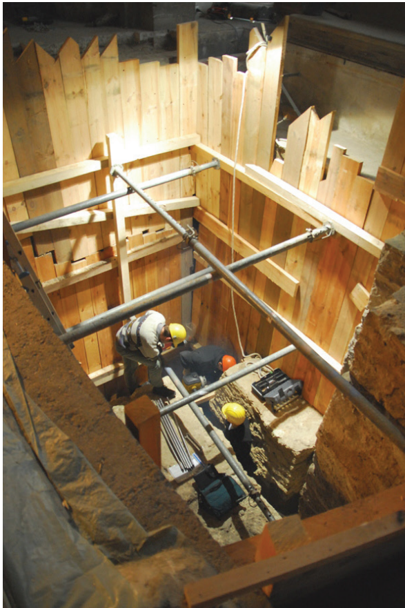
Abb. 9: Vorbereitung der Rammkernsondierung unterhalb des Kenotaph von Editha (HARTUNG, 2010)
