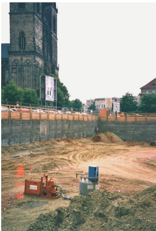
Abb. 5: Baugrube der Nord LB (HUBBE 2000).
