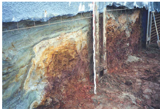
Abb. 6: Festgesteinsaufschluss (Rotliegend) an der Südostseite der Baugrube Nord LB (HUBBE, 2000)
