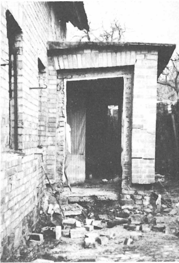
Photo 4 Überschwemmung der Thälmannstraße in Helfta infolge Rückläufigkeit des Kuhschluchtbaehes im Pressungsbereich der Hauptsenkungswanne und Aufpressungen der Pflasterdecke im Vordergrund (Photo BRENDEL)
