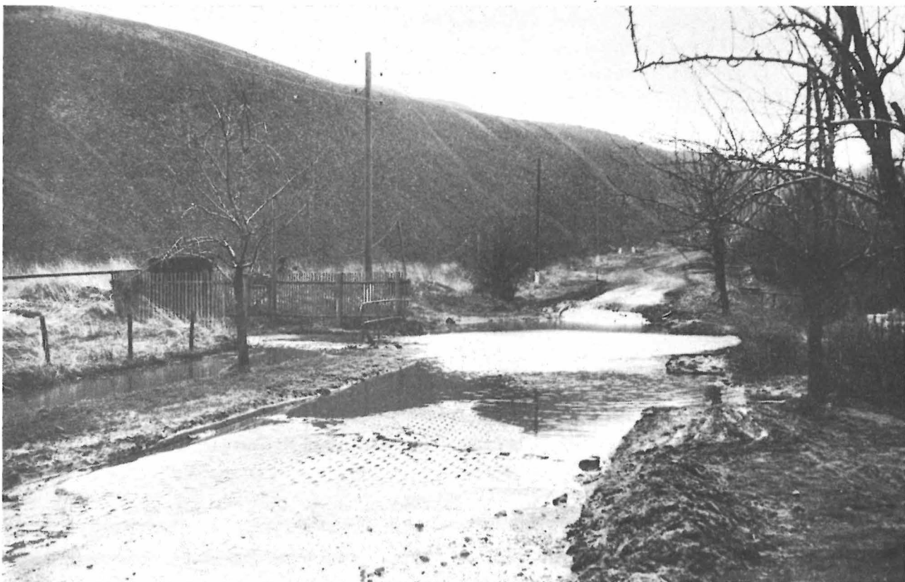
Photo 4 Überschwemmung der Thälmannstraße in Helfta infolge Rückläufigkeit des Kuhschluchtbaehes im Pressungsbereich der Hauptsenkungswanne und Aufpressungen der Pflasterdecke im Vordergrund (Photo BRENDEL)
