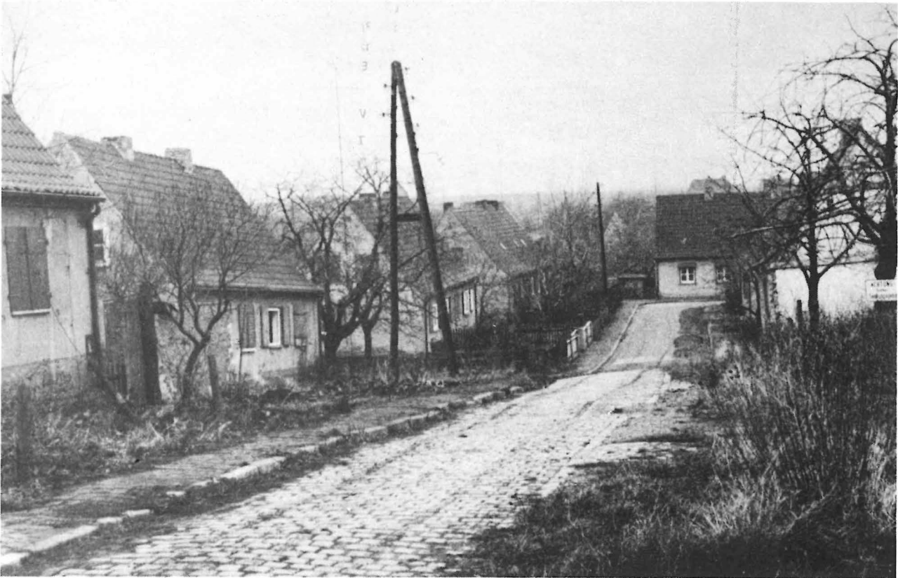
Photo 2 Blick auf den Senkungshang der Hauptsenkungswanne in Helfta mit schiefgestellten Häusern (Photo BRENDDEL)
