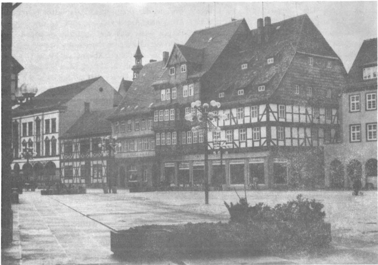
Photo 1 Marktplatz der Stadt Quedlinburg (Photo RABENER)
