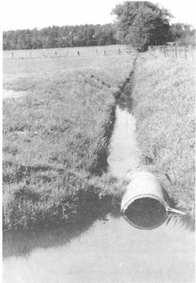
Photo 6 Rückstau vom Haupt- in einen Nebenvorfluter (Augraben)
