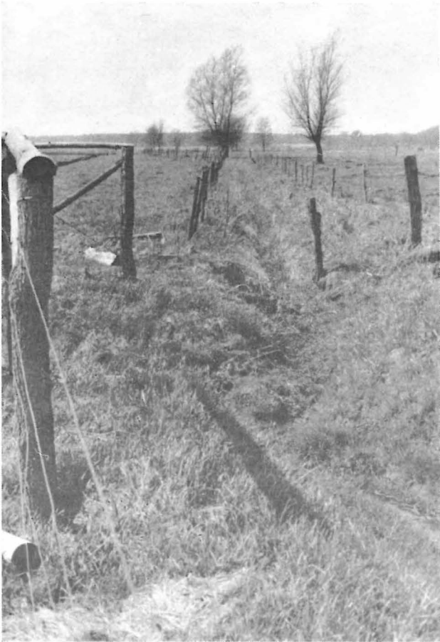
Photo 5 Verwachsener, funktionsuntüchtiger Binnengraben in der Secantsgrabenniederung
