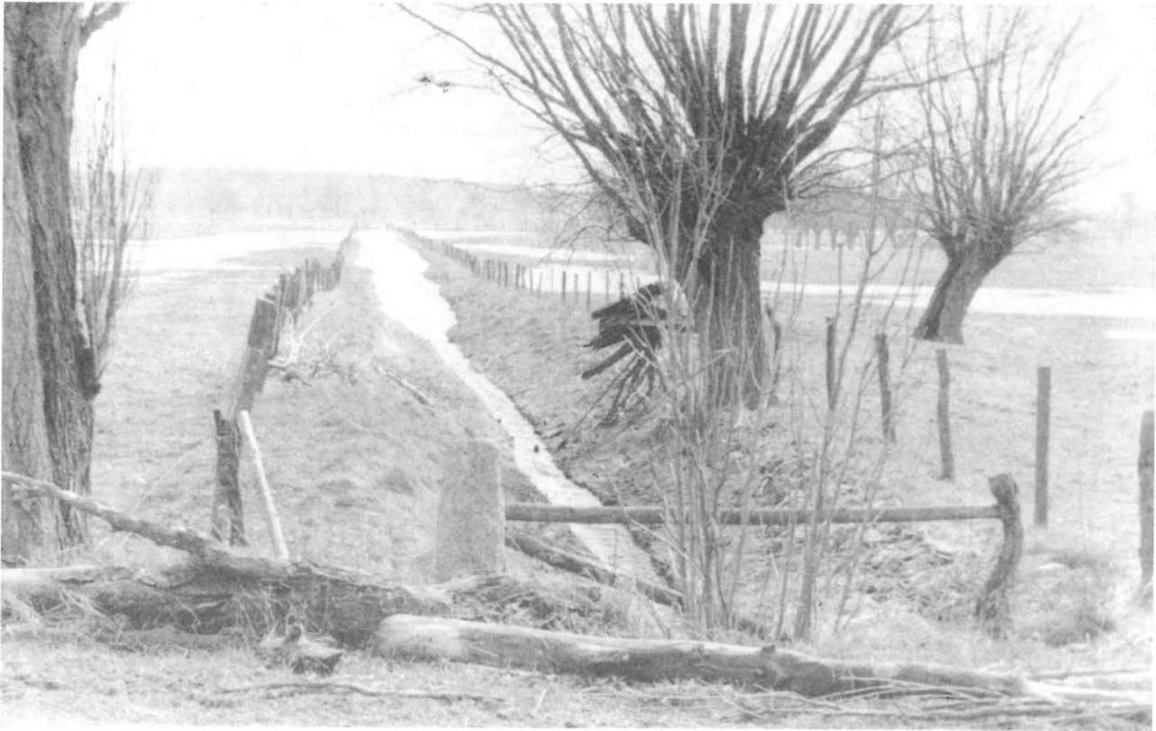
Photo 3 Mangelhafte Vorflut, kombiniert mit Rückstau vom Haupt- in einen Nebenfluter in der Biesenniederung
