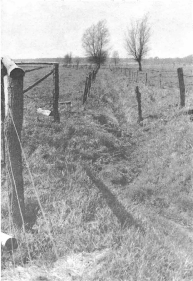
Photo 5 Verwachsener, funktionsuntüchtiger Binnengraben in der Secantsgrabenniederung
