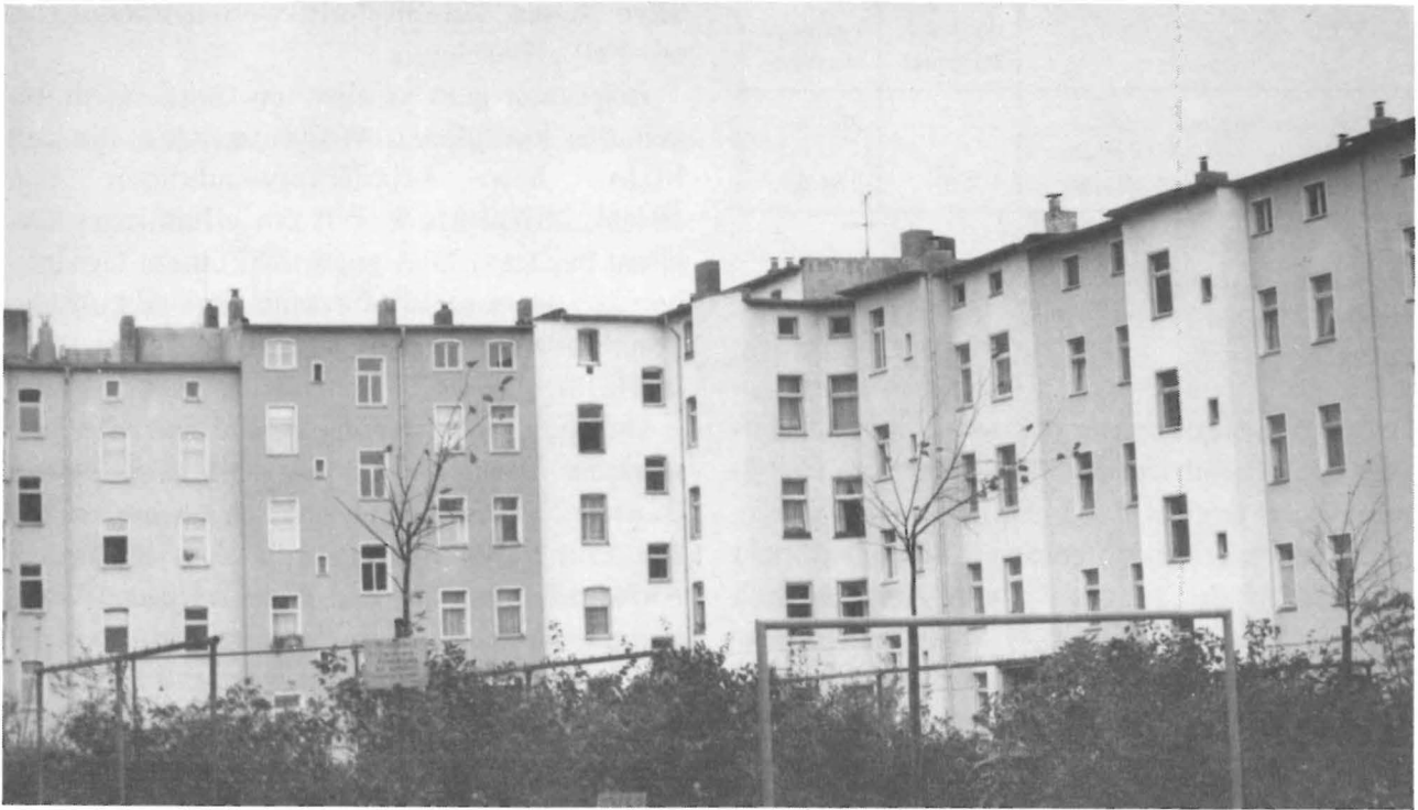
Photo 3 Entkernte Seiten- und Hinterhofquartiere
