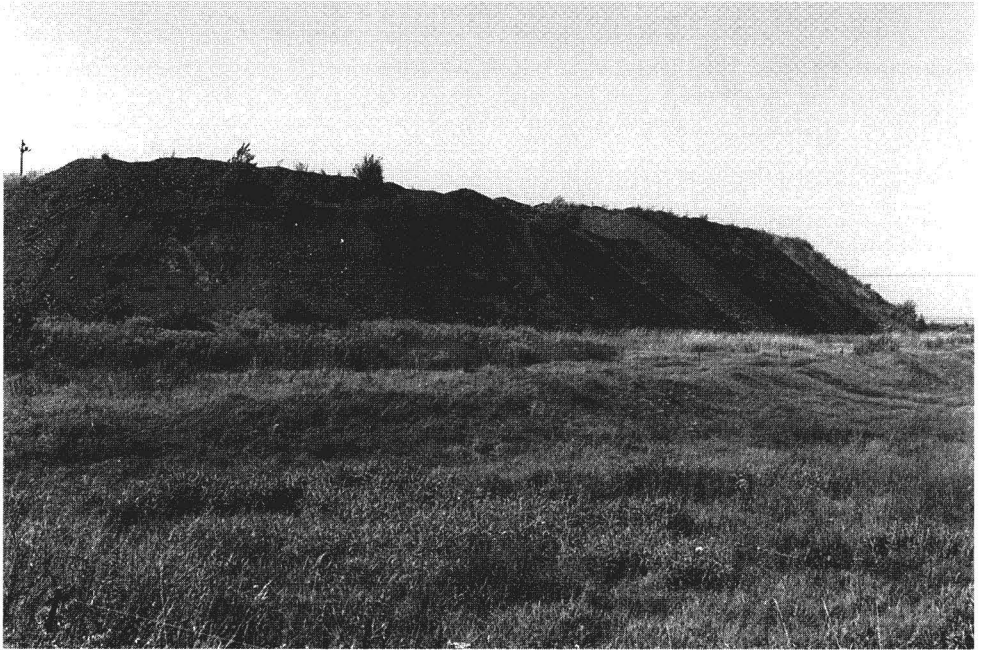
Abb. 1 Die Halde Korbußen: Die aus den Bergbauhalden austretenden Sickerwässer führen zu einer allmählichen Vernässung und Versalzung der unmittelbar angrenzenden Flächen.
