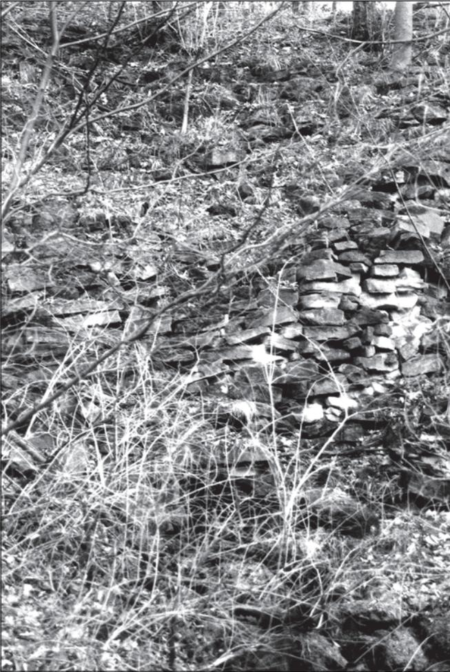
Abb. 6: Der aus dem Steinbruch (s. Abb. 5) gebrochene Sandstein wurde zur Errichtung des abgebildeten Dammes verwendet. Damit waren die südlich gelegenen Waldflächen des Grabeholzes mit Fuhrwerken erreichbar.
