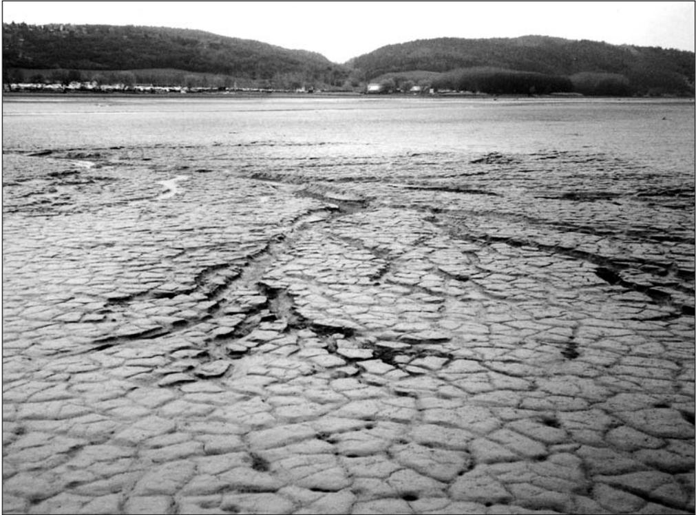
Abb. 9 Rückschreitende Erosion mit Schrumpfungsrissen in der Talsperre Kelbra
