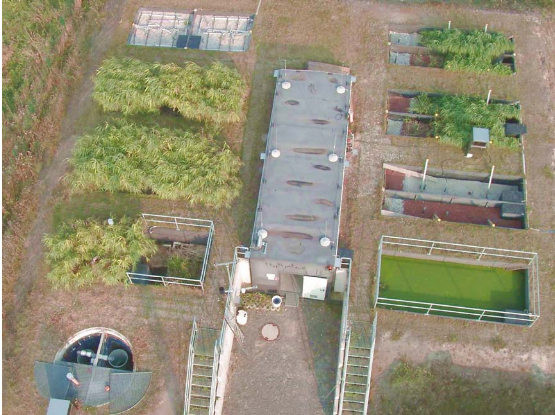
Abb. 2: UFZ-Pilotanlage in Langenreichenbach (Sachsen) (Foto: André Kuenzelmann, UFZ)
