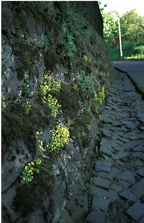
Abb. 16 Mauergesellschaft mit der Art Saxifraga cymbalaria , CZ, Jánská, Steinmauer in der Gemeinde an der Straße nach Česká Kamenice, 5.9.2000, Handrij Härtel.
