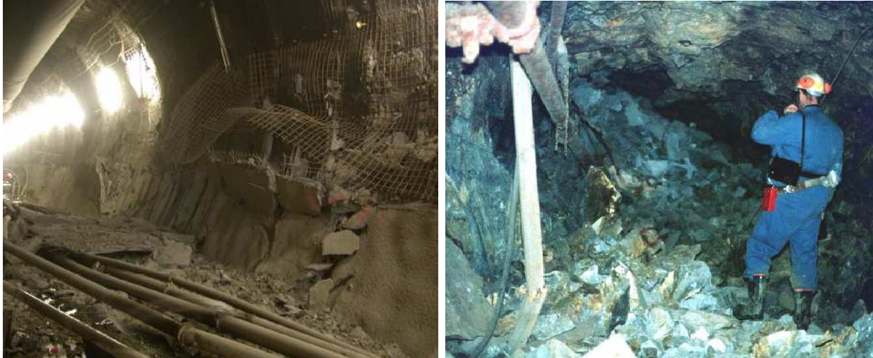
Abb. 2: Beeinträchtigung der strukturellen Integrität von Hohlraumbauten durch Bergschlag: links: Beschädigung der Ausbruchsicherung im Gneis durch Bergschlag, AlpTransit Gotthard-Basistunnel (Rehbock-Sander & Gerdes 2005) rechts: Zusammenbruch des gesamten Hohlraums durch einen massiven Bergschlag im Erzbergbau (Hoek 2000)
