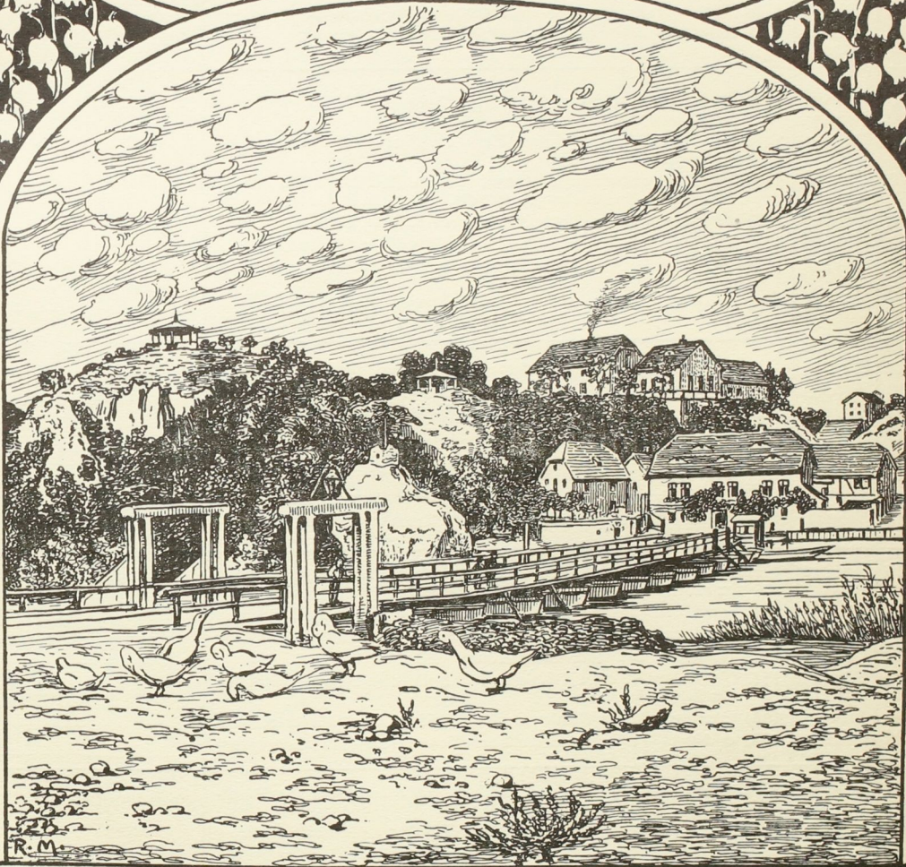
Die alte Pontonbrücke
