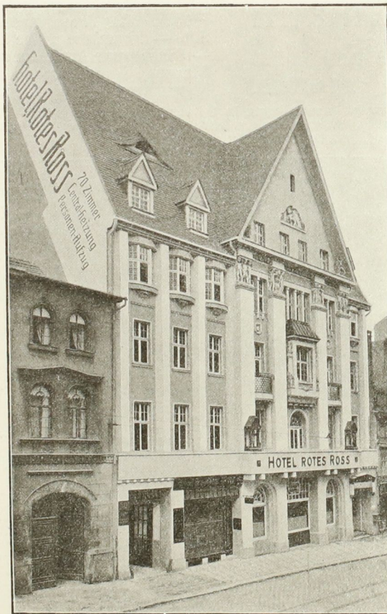
Der im Jahre 1911 entstandene Neubau des Hotels
